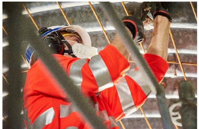
*Mise en place du ferrailage.*
