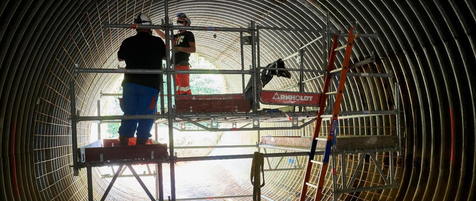
Dans le cadre du programme d'entretien et de maintenance de son infrastructure, VINCI Autoroutes procède actuellement à la mise en œuvre d'un procédé innovant, mis au point par l'entreprise Freyssinet pour renforcer un passage agricole situé sous l'autoroute A64 dans le secteur de Tarbes. Le déploiement de ce procédé sur ce type d'ouvrage présente de nombreux avantages techniques et pourrait répondre aux enjeux de préservation de la transparence notamment écologique de l'autoroute.
